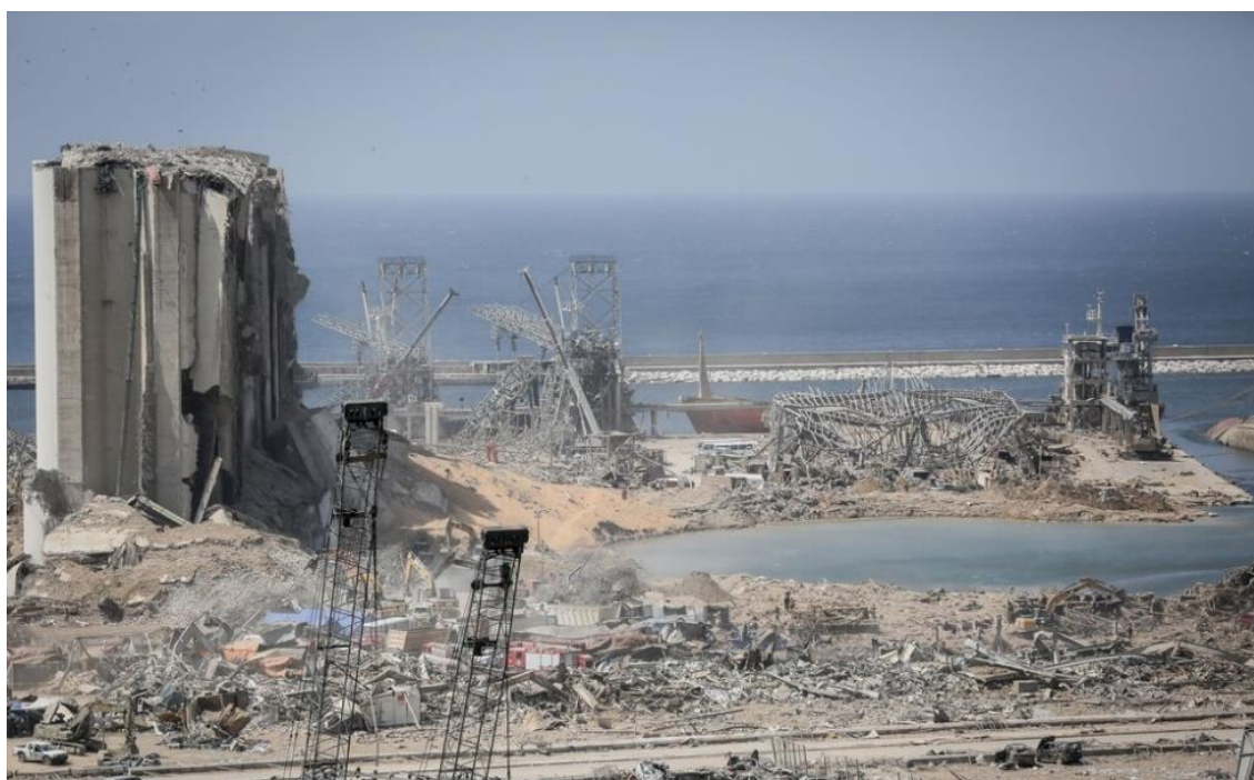
Разрушения на месте взрыва
